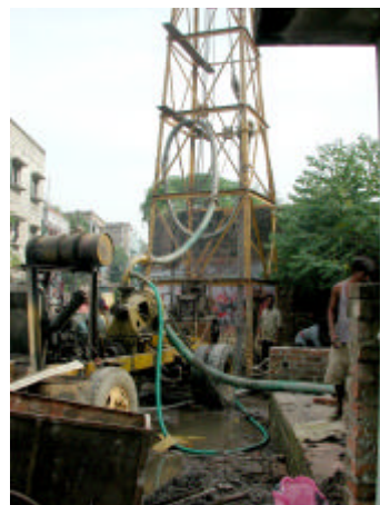
Trinkwasserbohrung 600 ft tief, 30cmØ
